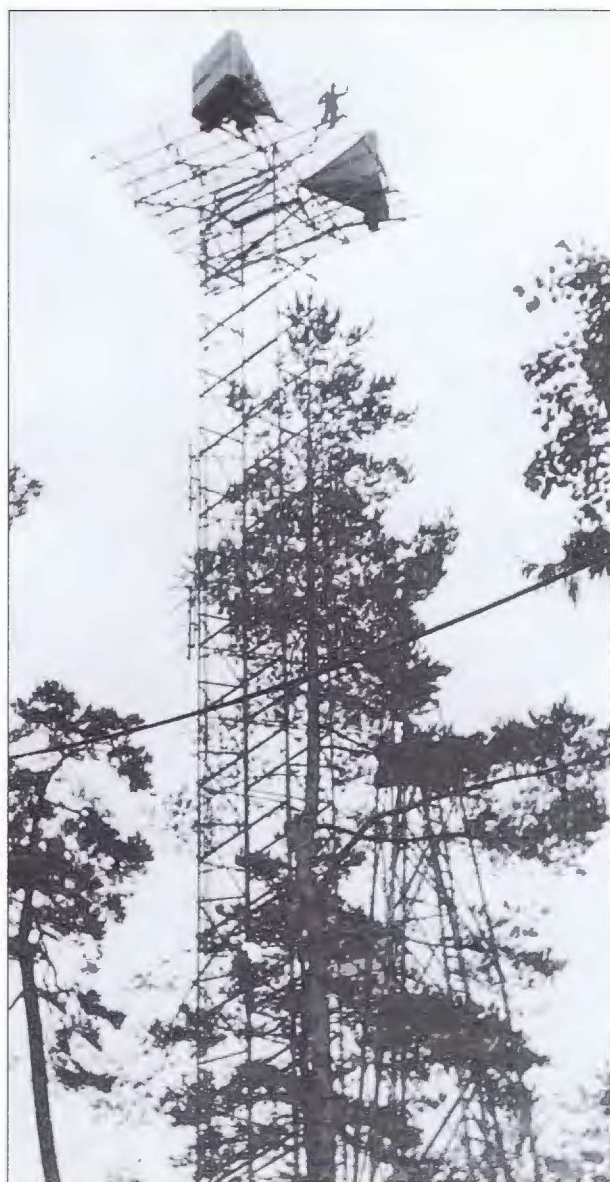
Antenntorn med två Siemens linsantenner
