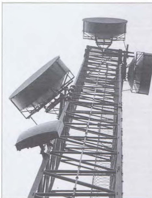
Parabolantenn med "krage" för RL-81
